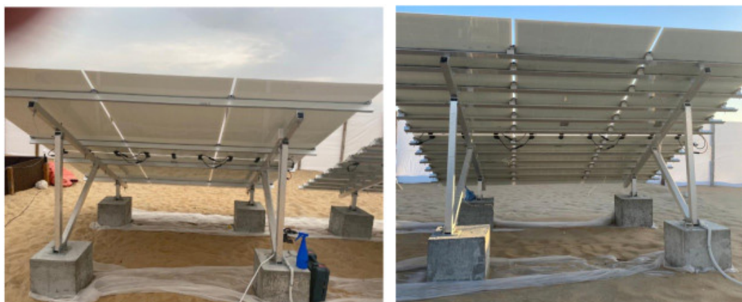
6-rasm. PV panelni o'rnatish-rafta tuzilishi: an'anaviy (chapda) va taklif qilingan (o'ngda)[8].
